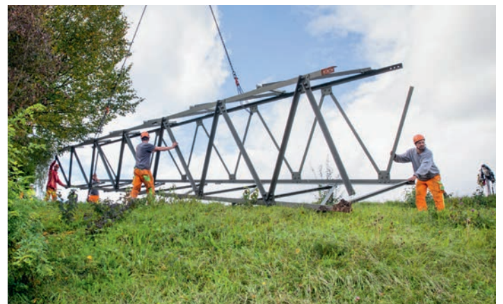
Im Oktober 2024 begann der Rückbau der alten Leitung im Raum Gattikon.
