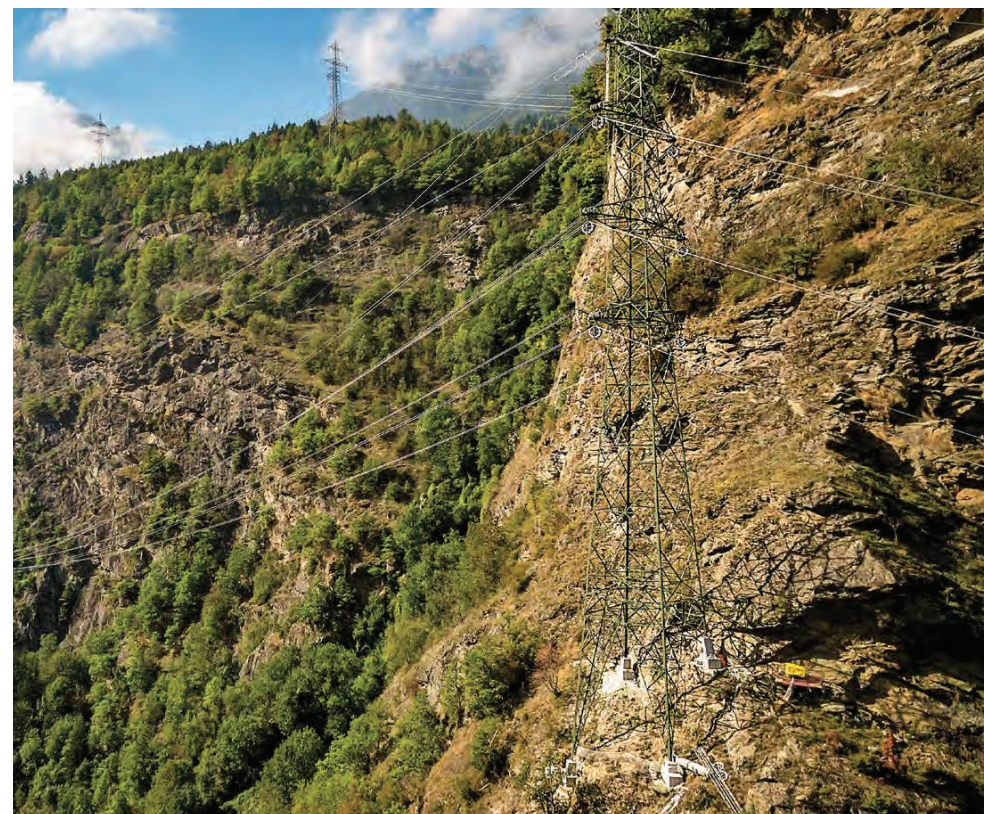
Steil über Schlucht: Ein Teilstück der neuen 380-kV-Leitung von Swissgrid im Oktober 2016 nach dem Seilzug – vorne rechts im Bild Mast 124. Sein Standort zählt zu den montagetechnisch anspruchsvollsten: eine nahezu senkrecht abfallende Felswand über der Trient-Schlucht.
