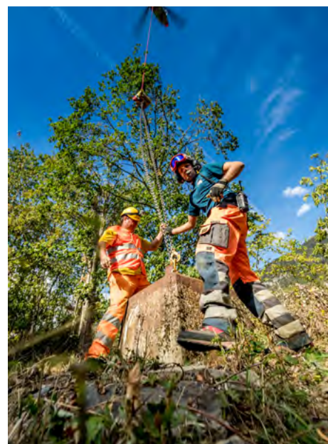
Démontage des socles de l'ancienne ligne Salvan, septembre 2018
