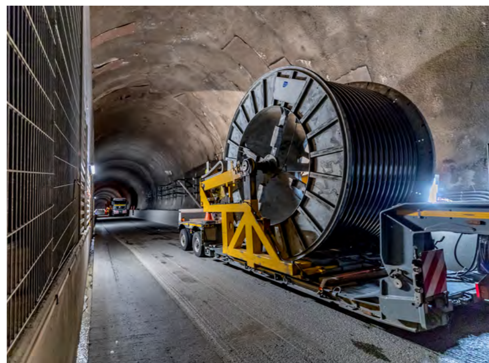
Pose des câbles dans la caverne, mai 2018
