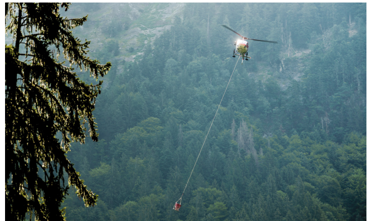
8 juillet 2015, travaux de bétonnage
