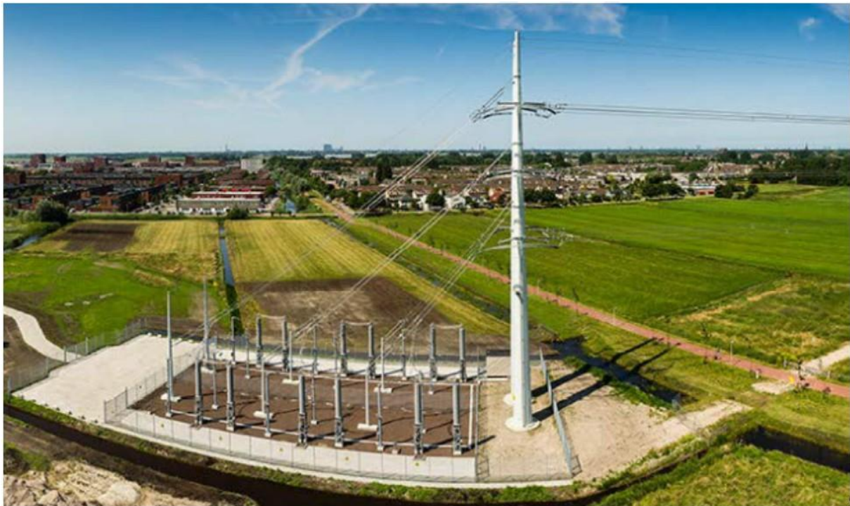
Abbildung 66: 380-kV-Zwischenverkabelung im Südring Amsterdam (Randstatt), Übergang vom Doppel-Mast (Wintrack) mit zwei OHL-Systemen auf zwölf Kabeladern (Quelle: Tennet, K. Jansen: „Underground cables in the 380kV network“, presentation 31. Jan. 2014, München)
