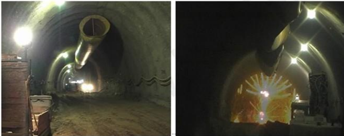
Abbildung 78: Wetterlutte in einem Tunnelquerschnitt (links), Sprengung an der Ortsbrust (rechts) [Bilder S & P]
