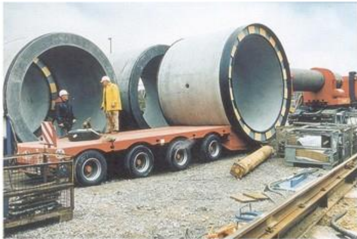
Abbildung 83: Anlieferung eines Vortriebsrohres (DN 3200, Länge 3,00 m, Gewicht 35 t) auf einem Spezial-Rohrtransporter [50]
