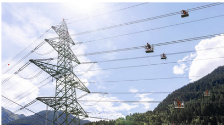
Bei dieser Bauetappe wurden die Abstandshalter unter spektakulärem Einsatz der Freileitungsmonteure montiert. Diese sorgen dafür, dass die Leiterseile bei Wind nicht aneinander schlagen.
