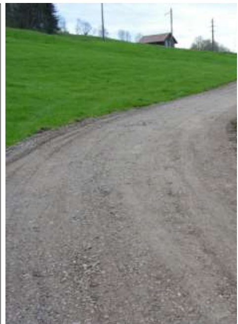
Abb. 15: Foto Exemplarische Baupiste
