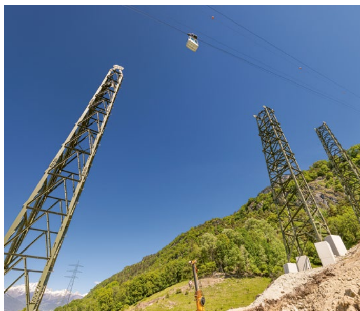
Le montage du pylône 162 à Chalais, mai 2022
