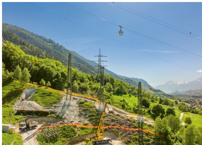
Le montage du pylône 162 à Chalais, mai 2022
