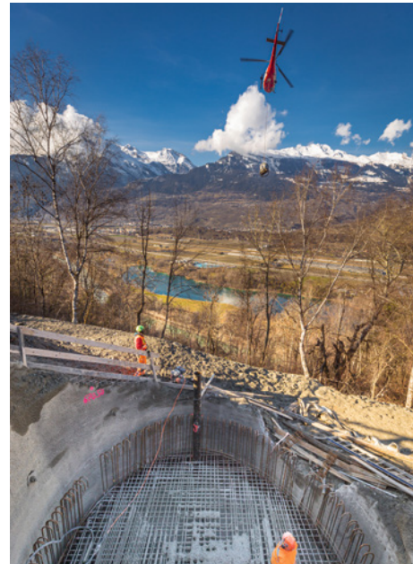
Construction des fondations du pylône 121 à Baar/Nendaz, mars 2021
