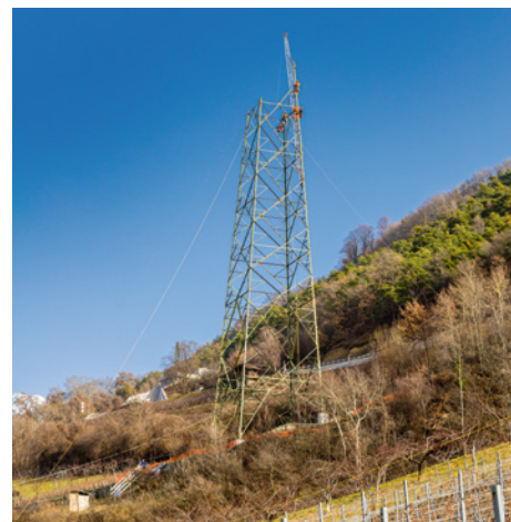
Le pylône 152 à Grône en cours de montage en février 2021
