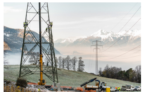
Le pylône 166 fera partie des pylônes entièrement montés au printemps 2020.
