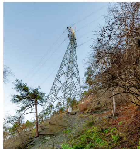
Pylône 2 de Chandoline.
