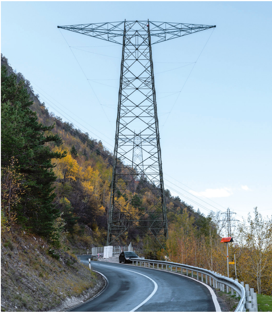
Installation d'un filet de protection provisoire entre les pylônes 171 et 172
