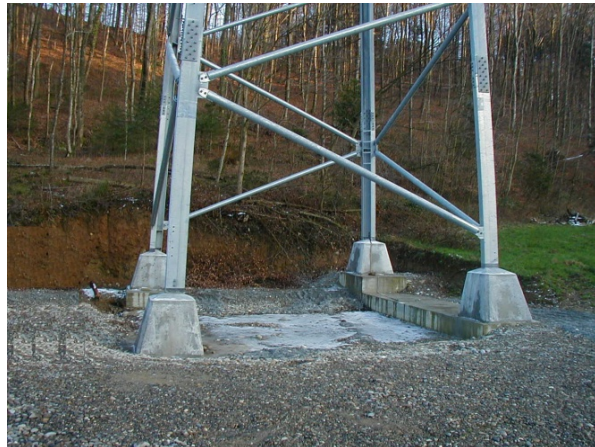
Fertiggestelltes Fundament mit Mastsockel
