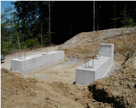
Riegelfundament im Bau
