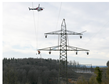
Die Vorseile werden grösstenteils per Helikopter herangeflogen ...
