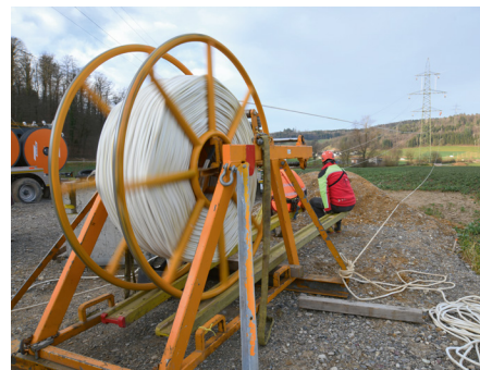
Impressionen vom Einzug der Vorseile, an denen entlang von Stahlseilen anschliessend die stromführenden Leiterseile hochgezogen werden.
