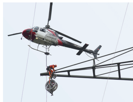
... und von den Freileitungsmonteuere in schwindelerregender Höhe an den Masten befestigt.
