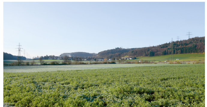
Blick von Nordosten Richtung Riniken. Links die heutige Leitung, die bis 2021 demontiert wird. Rechts die neue Leitung, die am und im Wald verläuft.
