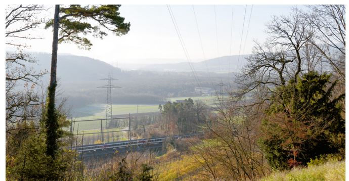
Südlich der Bözbergstrasse, unter der heutigen Leitung, die bis 2021 demontiert wird: Unten das Übergangsbauwerk Süd. Links die neuen Masten, welche das Tal der Aare Richtung Habsburg überqueren.
