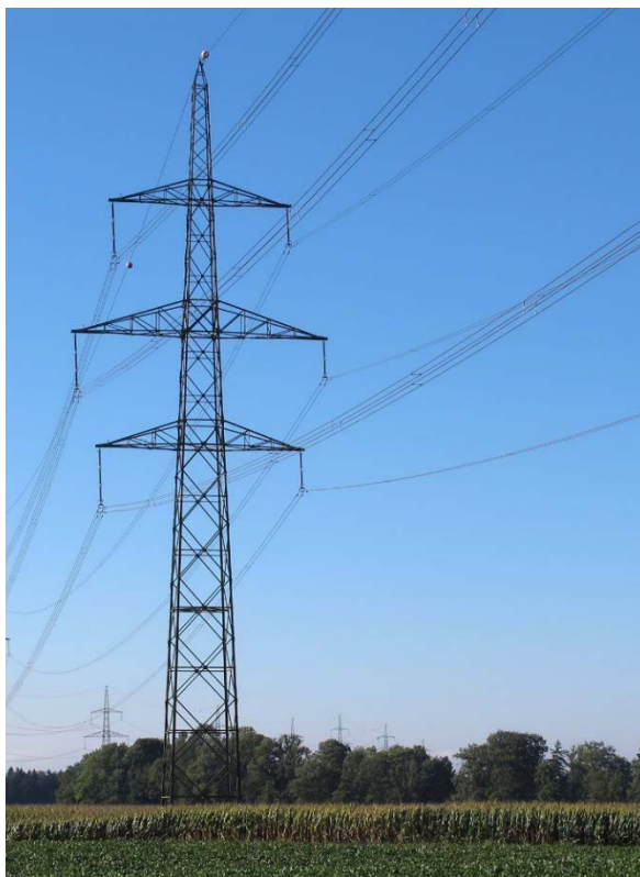
Silhouette de pylône existant avec chaînes de suspension simples
