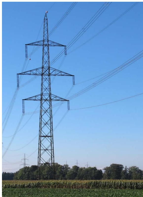
Silhouette de pylône après montage de chaînes de suspension doubles
