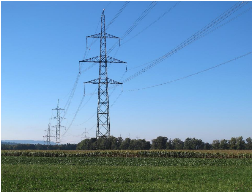
Silhouette de pylône existant avec chaînes de suspension simples
