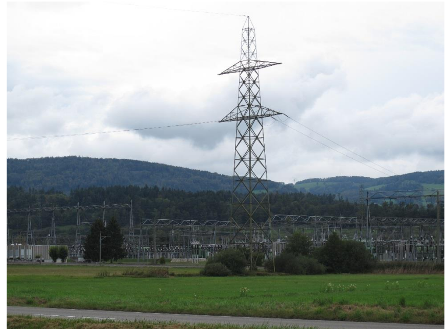
Pylône n° 140-2 Bassecourt
