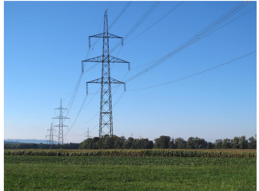
Silhouette de pylône après montage de chaînes de suspensions doubles
