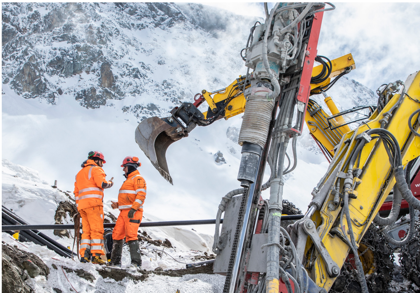
Établissement des fondations des pylônes au col de l'Albula (GR)
