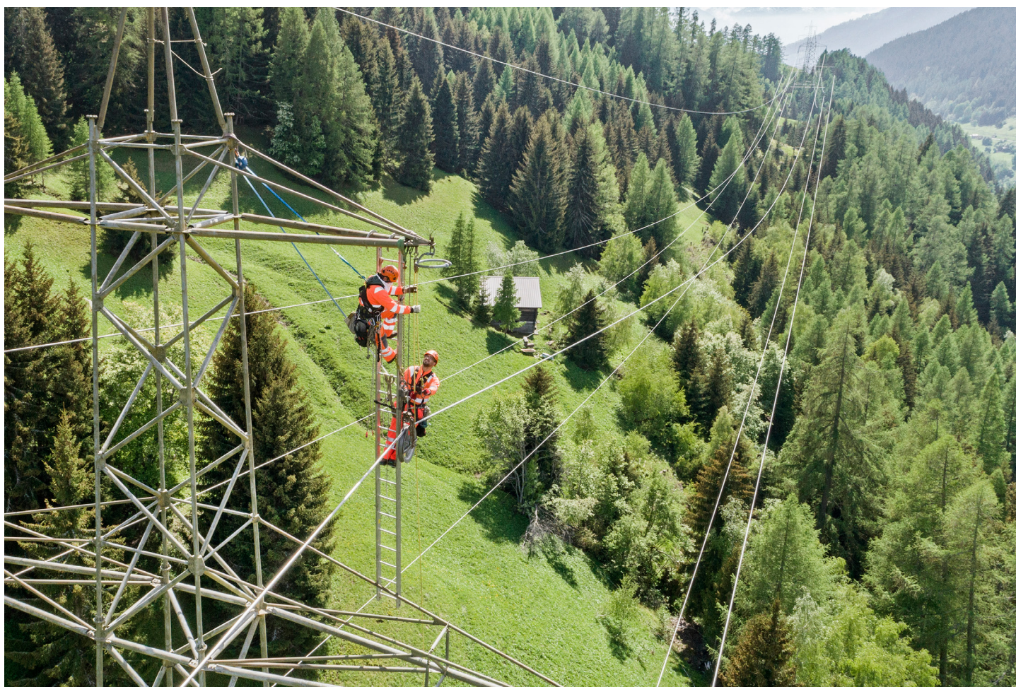
Démantèlement de la ligne Mörel–Ulrichen (VS) de 220 kV
