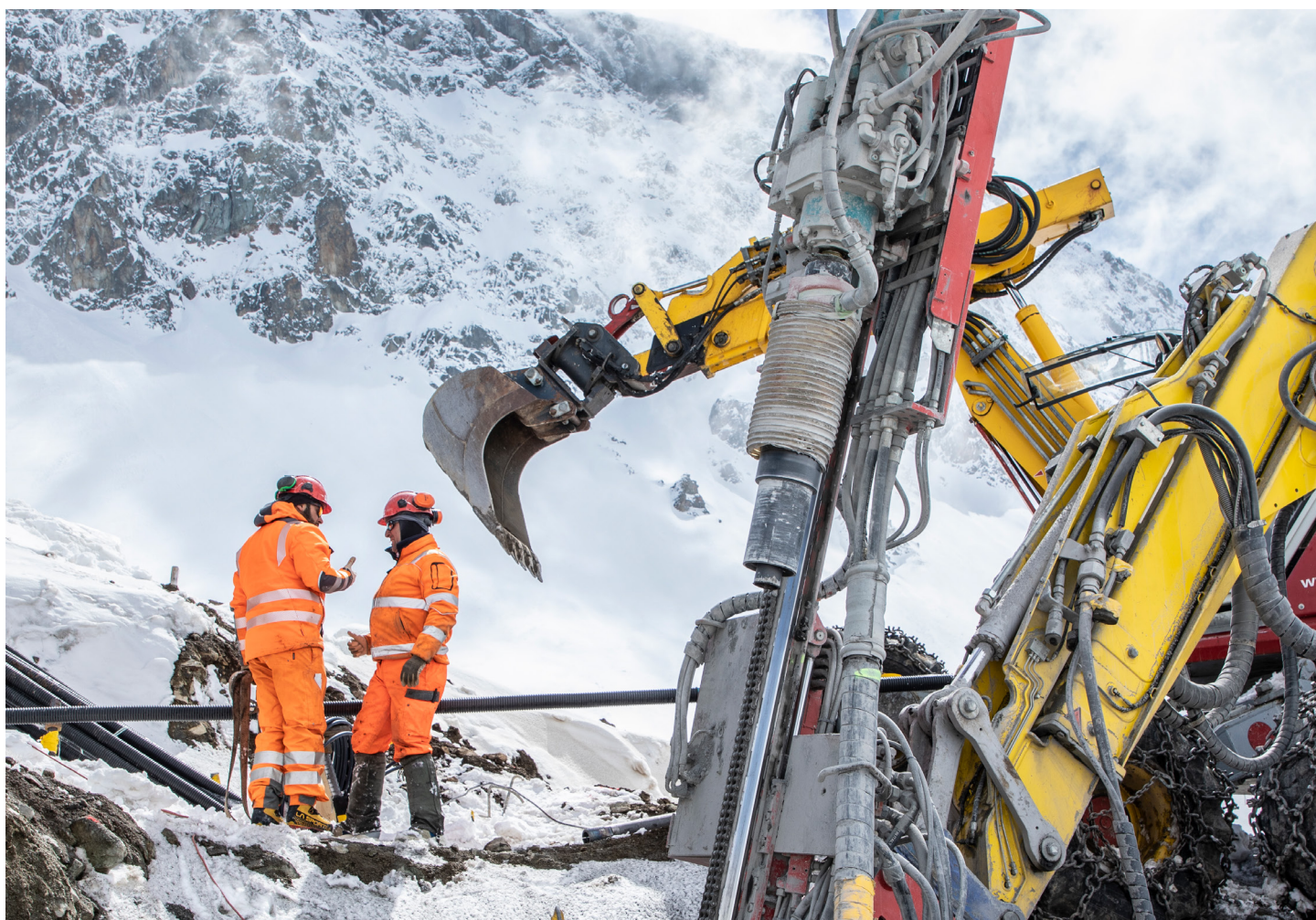
Costruzione delle fondamenta dei tralicci sul Passo dell'Albula (GR)
