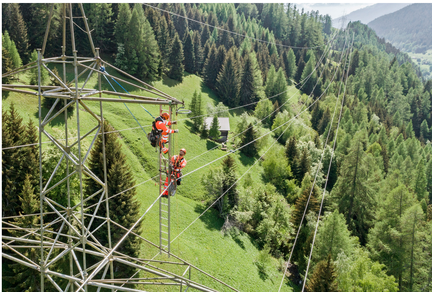
Smantellamento della linea 220kV_Mörel - Ulrichen (VS)
