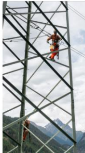
Schusspunkt mit grüner Farbe: Malerarbeiten in kühler Höhe Punct final cun color verda: lavurs da pictur en autezzas sruovalas
