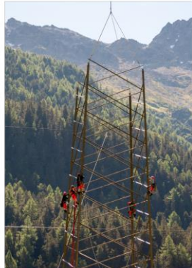
In schwindelregender Höhe demonstrieren die Monteur einen Mast. En autezzas sruovalas demonteschian ils montaders ina pilga.
